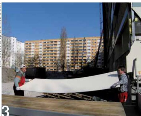
Foto: Bösecke Spezialbau GmbH
